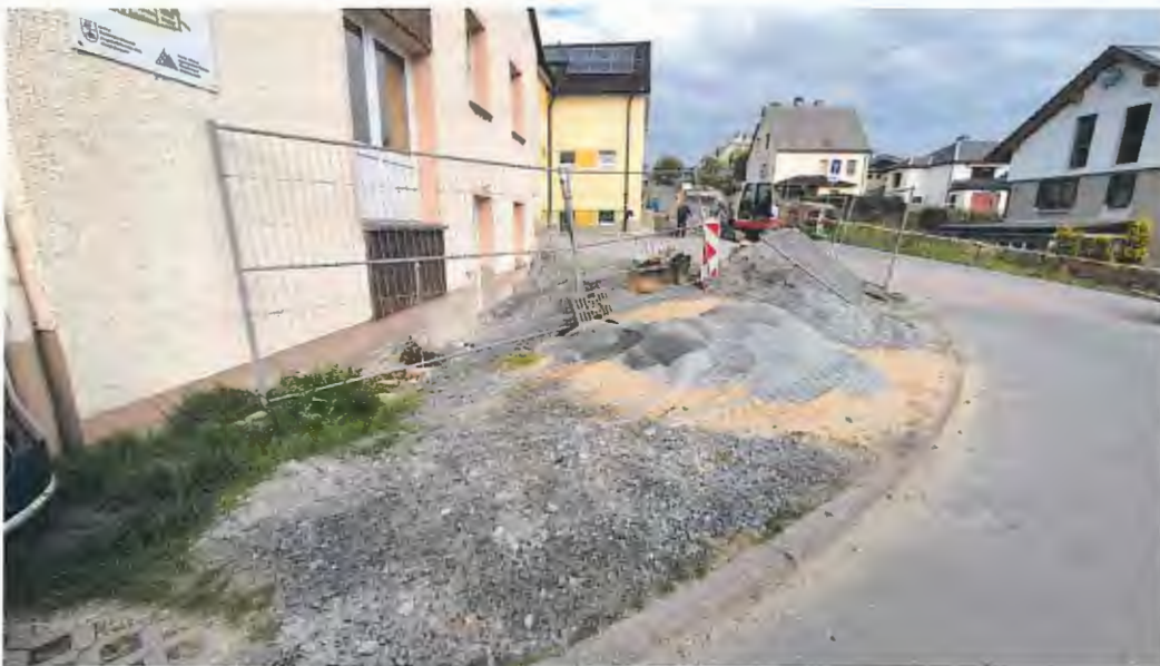
Fläche vor Ostflügel Sicht in Richtung Rosenweg (im Hintergrund neues Wirtschaftsgebäude)
